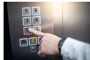
Aufzug mit Blindenschrift und Sprachansage
